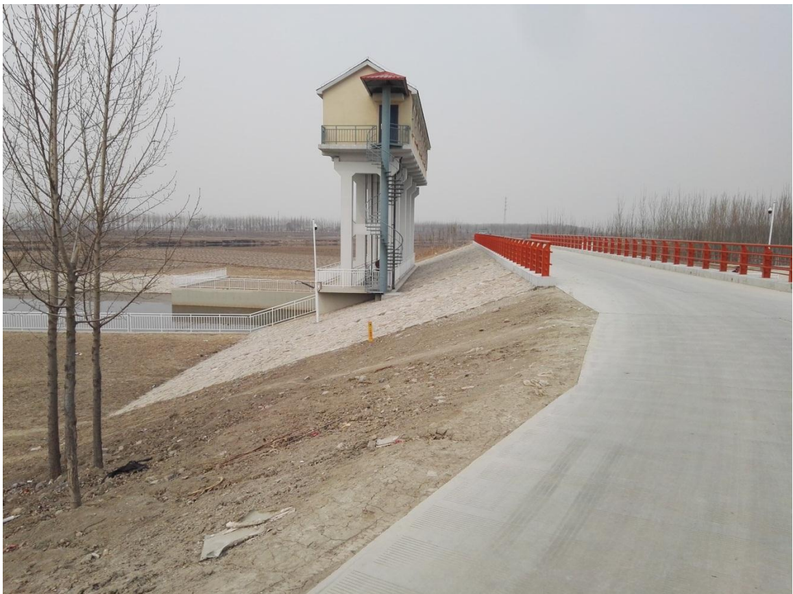
除险加固后的魏甸闸
