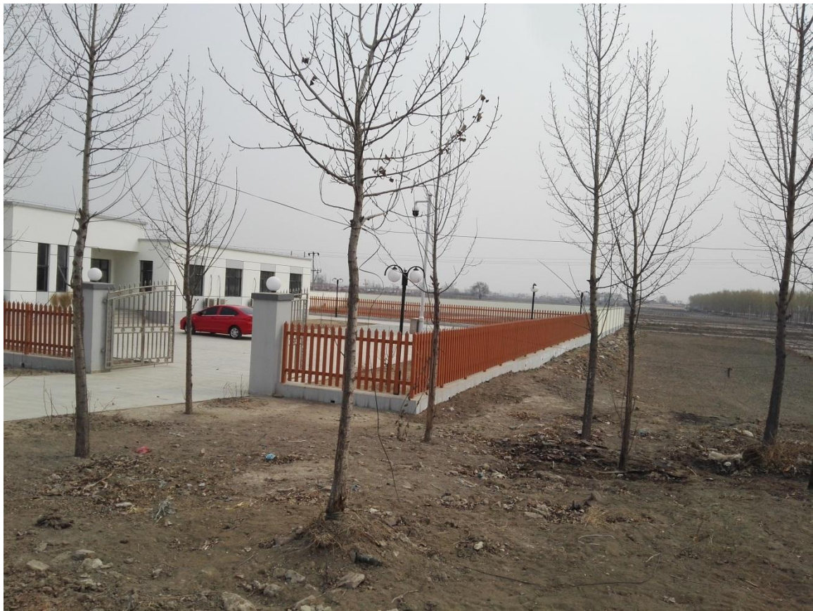
原施工营地（现为新建闸管所）
