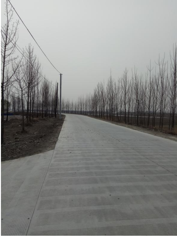
闸管所门前新建道路
